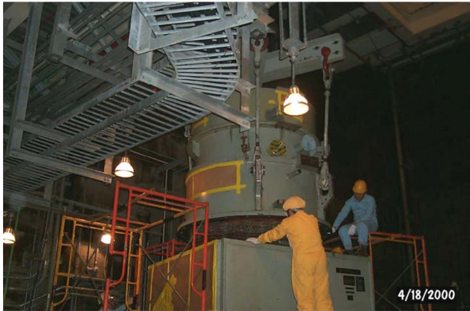
ROTOR含上部組件吊回至STATOR本體
