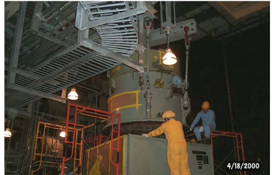
ROTOR含上部組件吊回至STATOR本體
